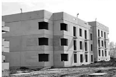
Рис. 2. Возведение дома из панелей
