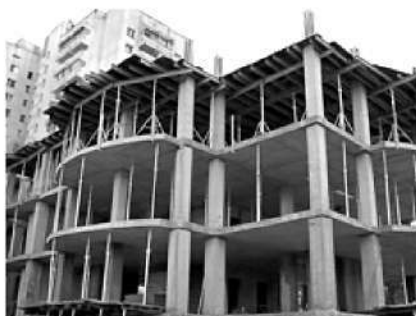
Рис. 1. Возведение монолитного железобетонного каркаса здания
