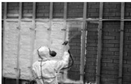
Рис. 1. Нанесение напыляемого пенопласта
