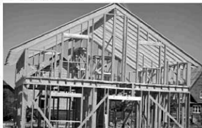
Рис. 3. Возведение деревянного каркаса здания
